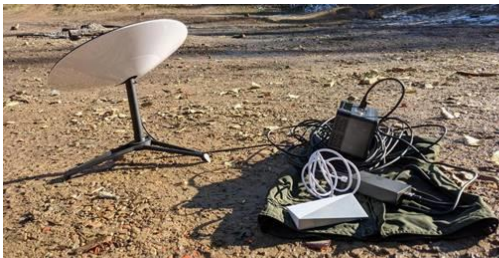
Рис. 5. Смонтированный терминал Starlink
