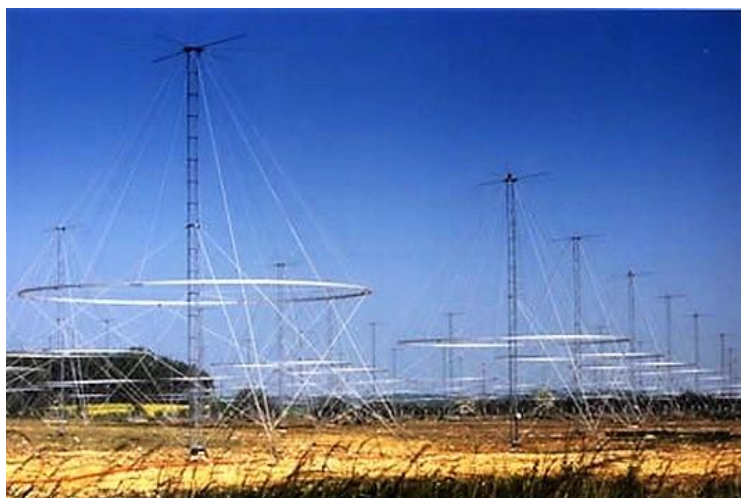
Рис. 1. Антенный элемент РЛС ЗГО NOSTRADAMUS
